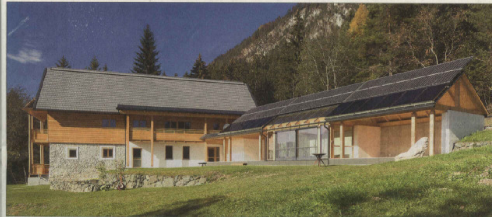
Die Architekten Ronacher rüsteten ein altes Bauernhaus zum Plusenergiehaus um und schlossen einen Neubau mit Fotovoltaikmodulen auf dem Dach an. [Architekten Ronacher]
