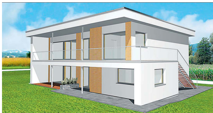
Die Strohbauweise bevorzugt eher einen modernen Baustil. Während die tragenden Mauern aus Stroh sind, besteht der vordere Bereich aus einer Holz- und Glaskonstruktion.
