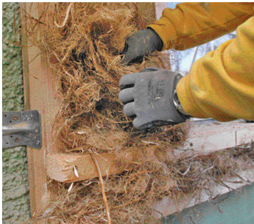
Ökologische Alternative. Hanfstopfwolle wird händisch in die Hohlräume in der Fassade hineingedrückt.
