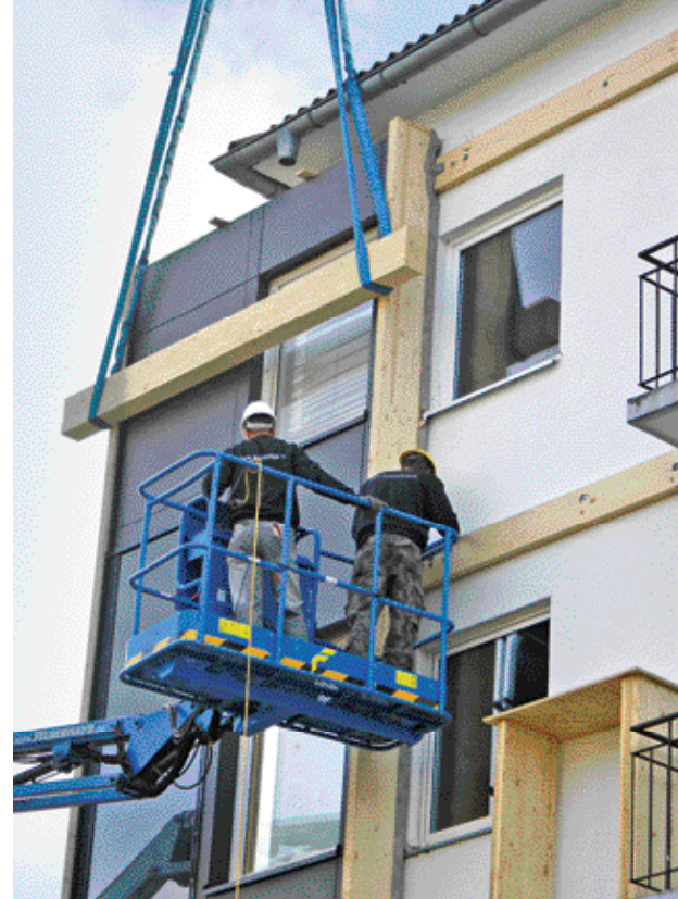
Außendämmung. Die einfachere Variante bei nachträglicher Dämmung ist meist, außen eine Dämmschicht aufzutragen.
